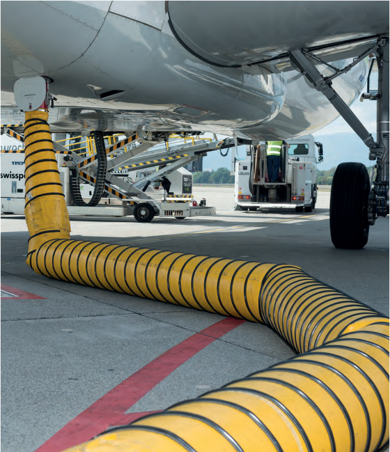
Avion alimenté en air conditionné par les nouvelles pompes à chaleur
