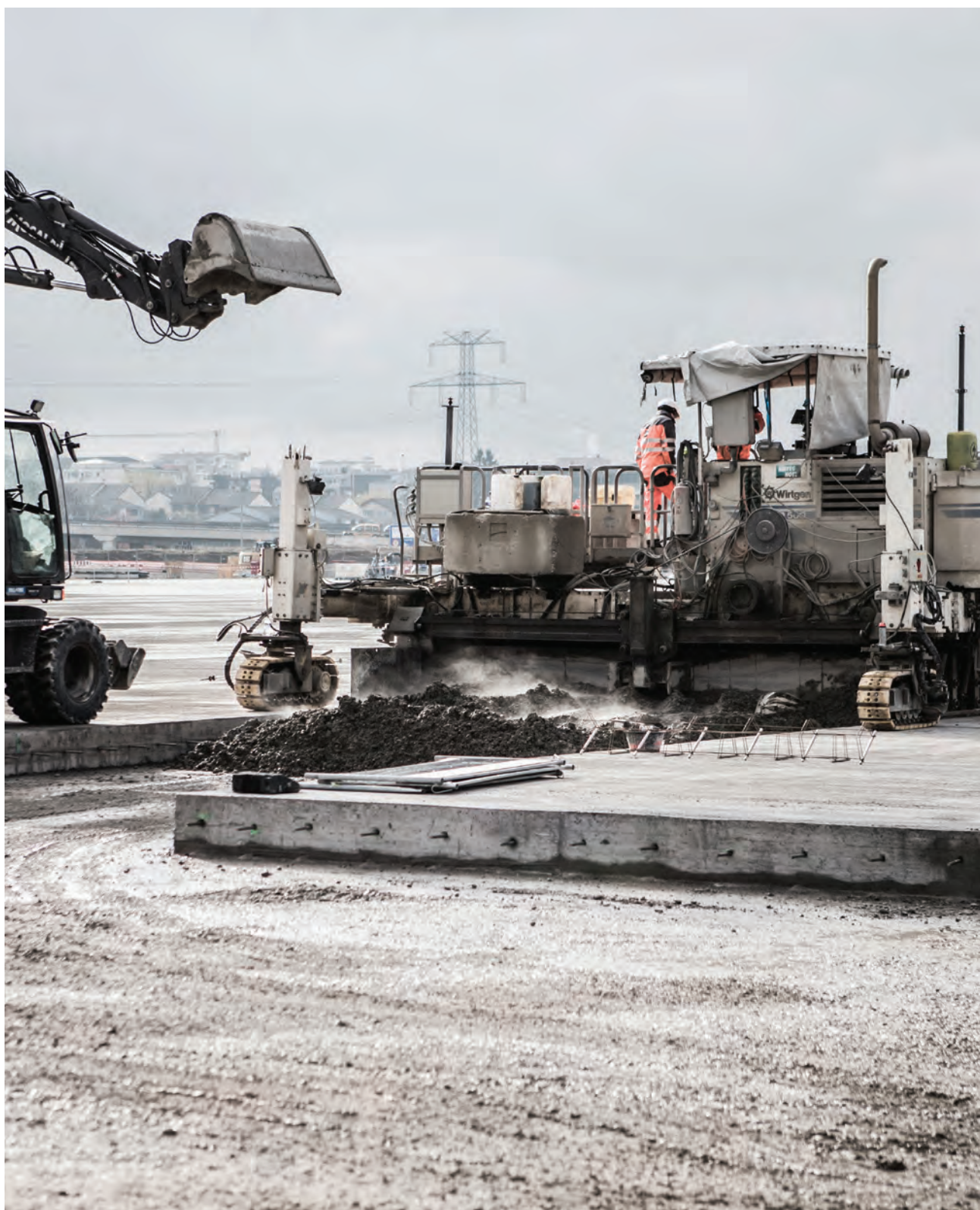
Travaux du parking P48
