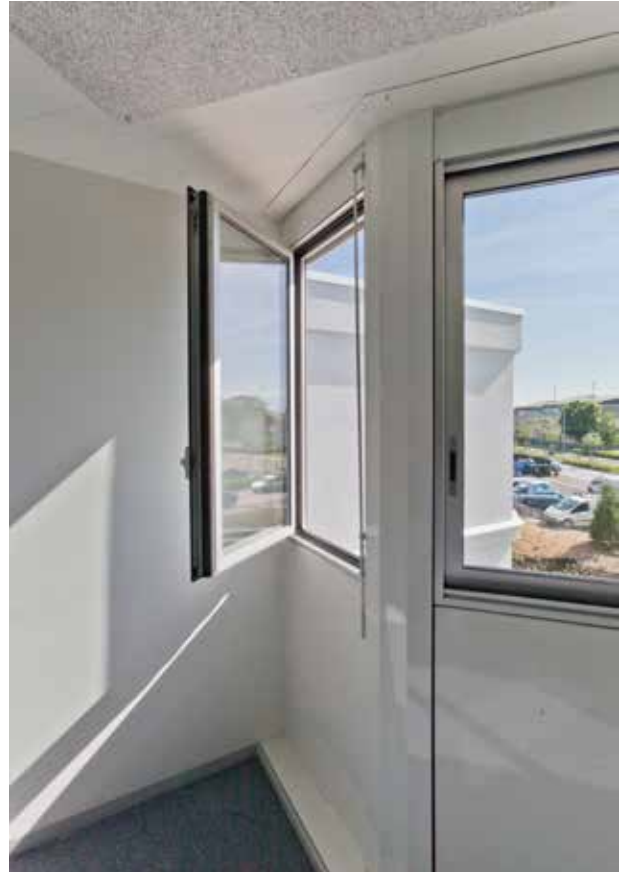
Commune de Vernier, fenêtres nouvellement posées.
